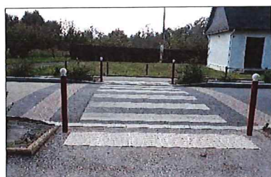
Passage piétons Rue du Porhoët
